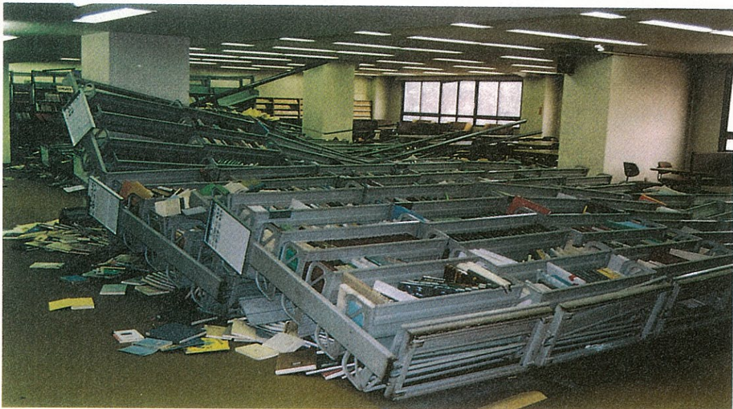
転倒したスチール書架 上部連結をしていたものの、スチール書架のほとんどが転倒した。
