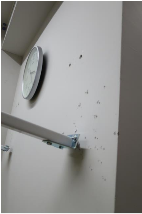
書架天つなぎ部材 (工学分館)
