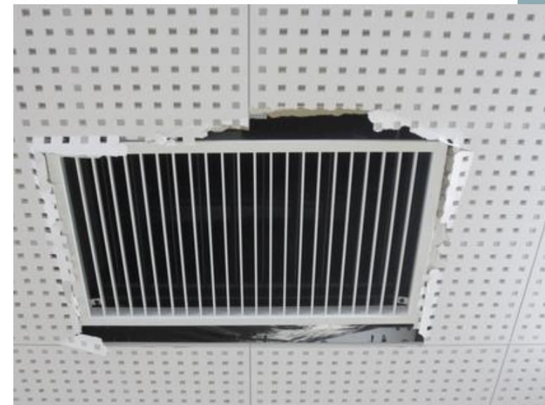
換気設備(医学分館)
