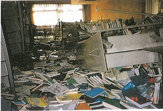
倒壊したスチール書架 上部連結のみのスチール書架が倒壊し、図書がことごとく散乱した。
