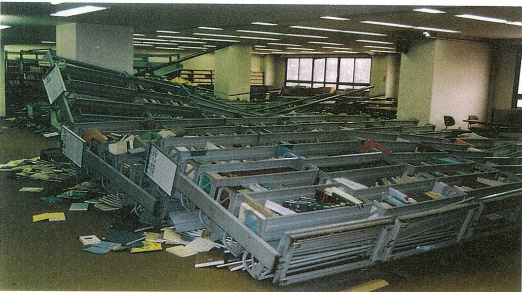
転倒したスチール書架 上部連結をしていたものの、スチール書架のほとんどが転倒した。
